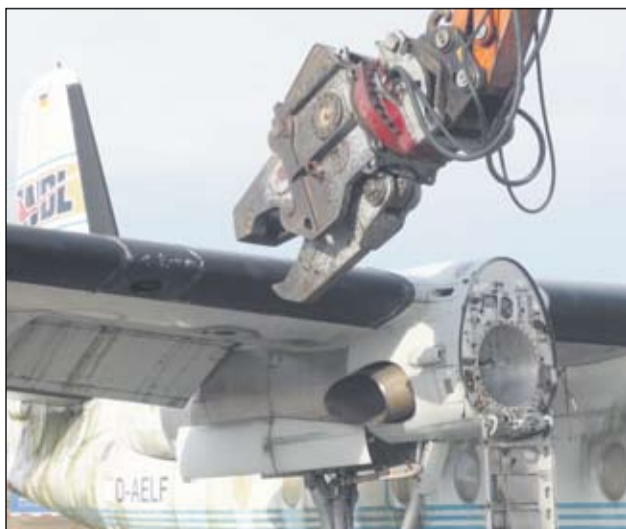
Met T-rex-achtige machines worden de vliegtuigen in stukken geknipt.
