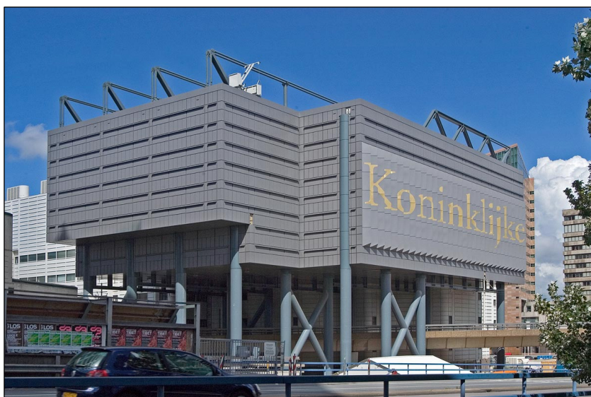
Figuur 4: Veiligheidsgeïntegreerd ontwerpen op gebouw niveau; een voorbeeld van een dichte gevel bij de Koninklijke Bibliotheek, Den Haag.
