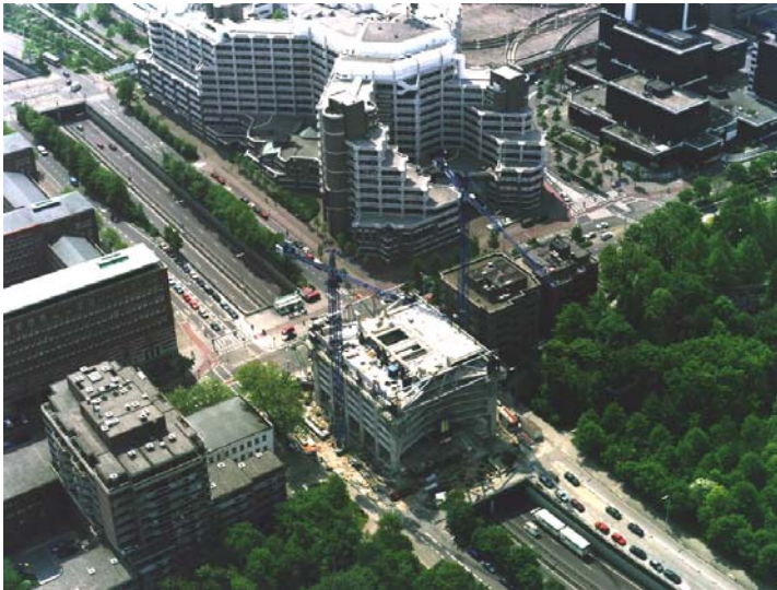
Figuur 6.10: Malietoren op de Utrechtse Baan in aanbouw, Den Haag
