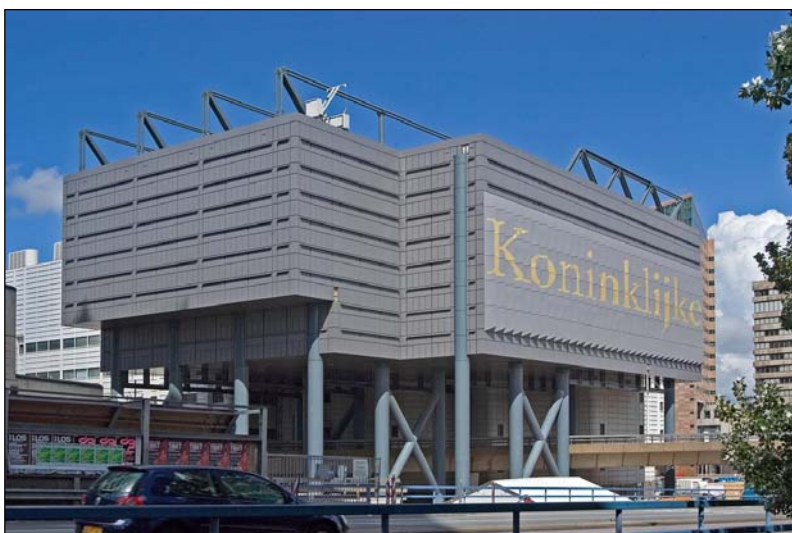
Figuur 5: Veiligheidsgeïntegreerd ontwerpen op gebouw niveau; een voorbeeld van een dichte gevel bij de Koninklijke Bibliotheek, Den Haag.
