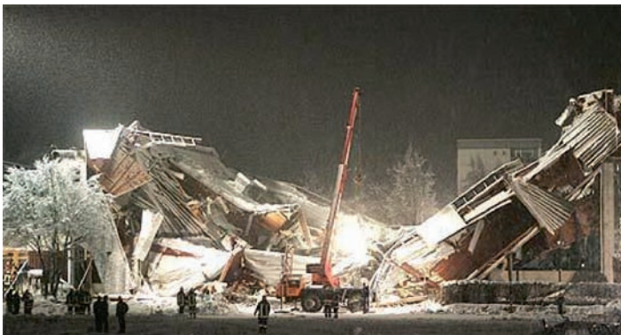
Figuur 1: Instorting ijsshal in het Beierse Bad Reichenhall
