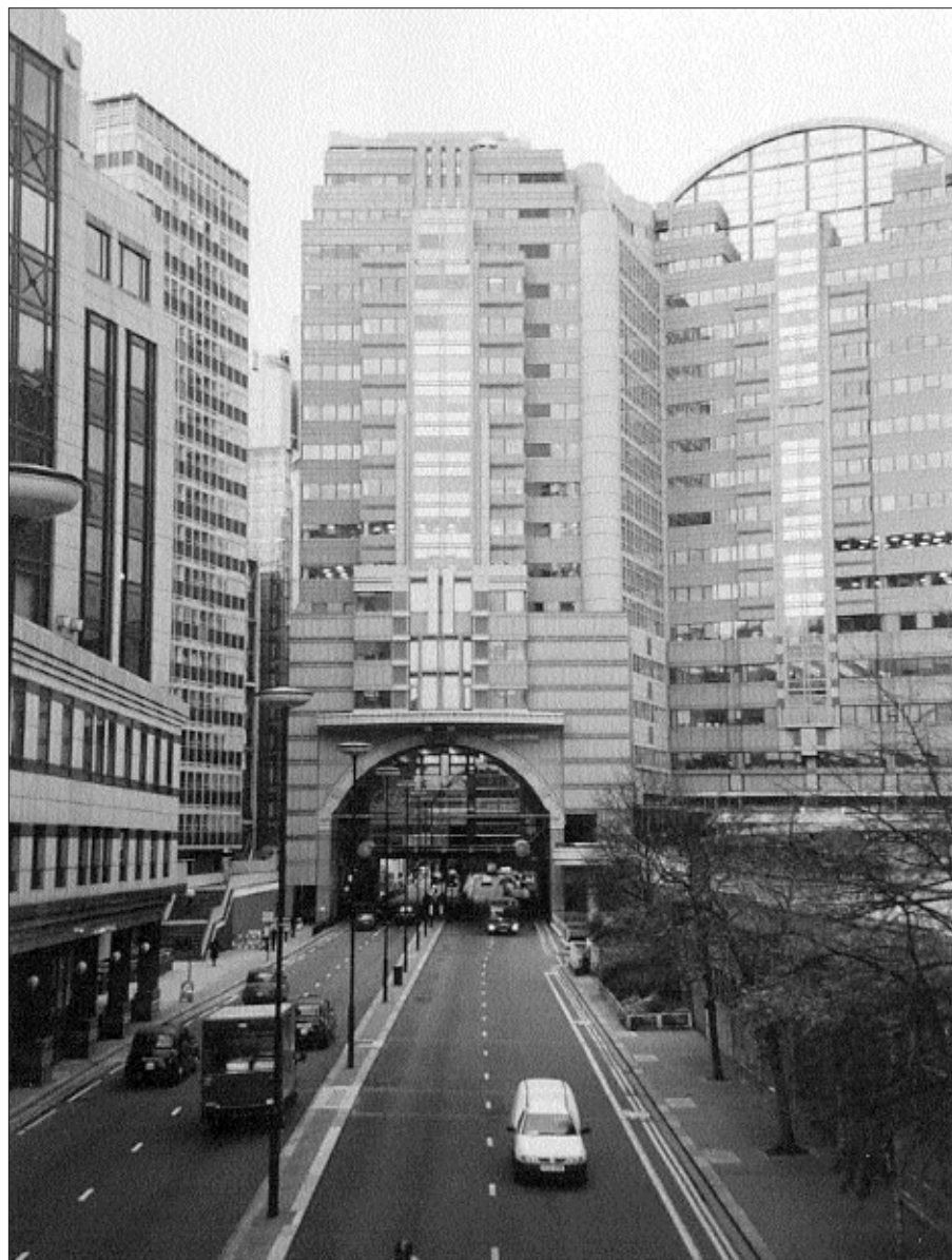
In Londen (London Wall) zijn grote overspanningen middelen boogconstructie en overgedimensioneerde kolommen gerealiseerd. Deze wijze van bouwen reduceert sterk de kans op een aanrijding van verkeer tegen de hoofdconstructie van het gebouw.
