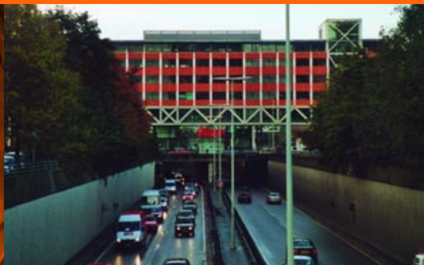
Bruggebouw west boven de Utrechtsebaan.
