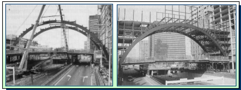
Figuur 6.25: De montage van de boogspant [Gal1993].
