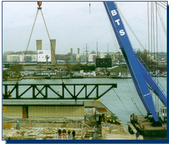
Figuur 6.31: Aanbrengen vakwerkligger [Kra1993].
