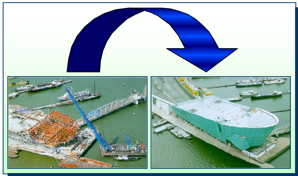
Figuur 6.32: Tijdens en na de bouw [Kra1993].
