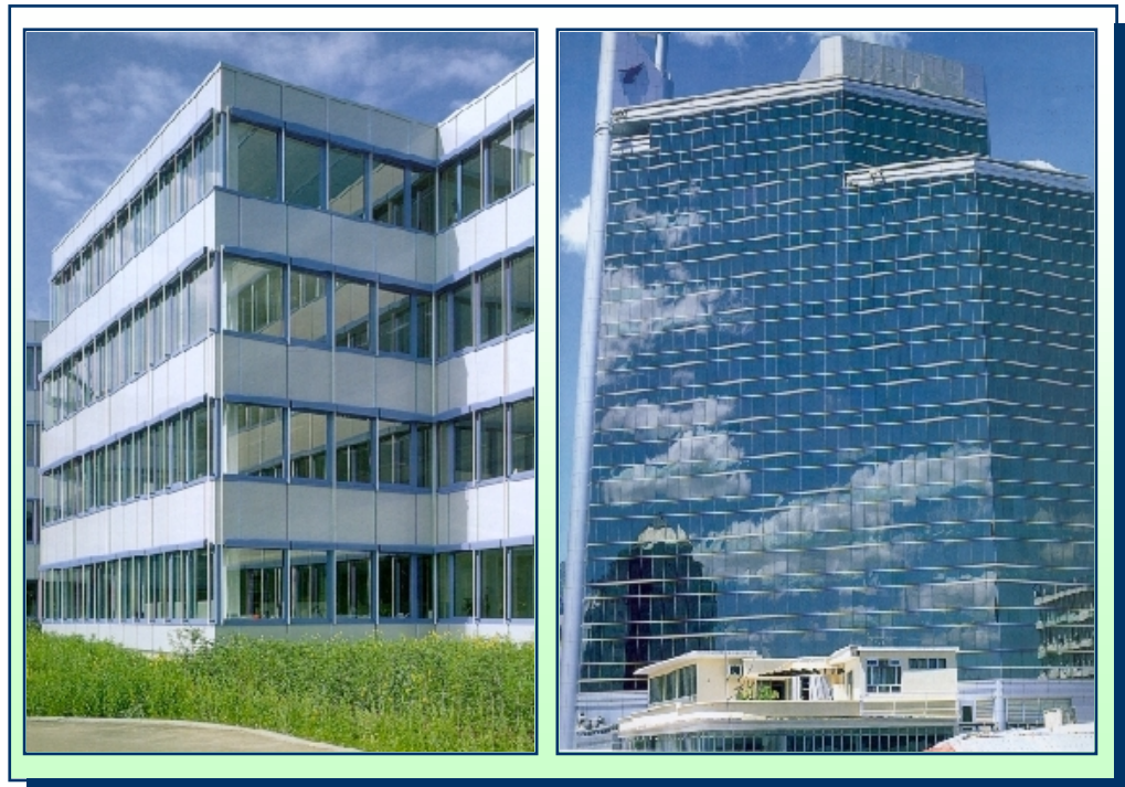
Figuur 12.4: Vlakke gevels van het Technologiecentrum en Telecom Center, Mauritius [Jos1997].
