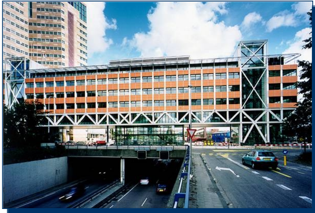
Figuur 6.10: Bruggegebouw West; Voorgeve [15].
