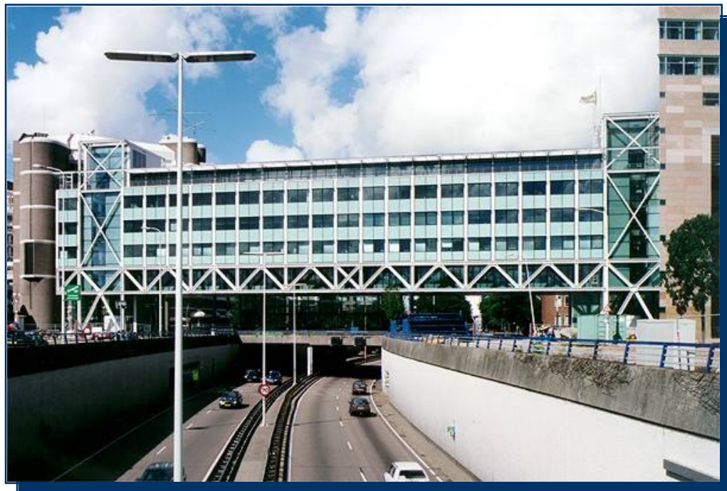
Figuur 6.11: Bruggegebouw West; Achtergevel [15].
