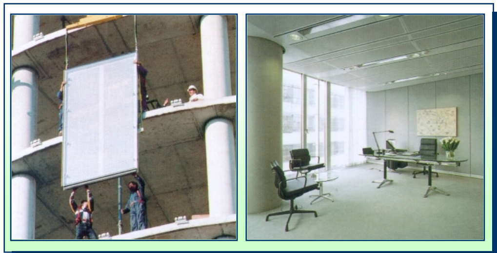
Figuur 12.5: Aanbrengen van de gevel van buiten uit en het interieur, in het Kornzernzentrale RWE [Jos1997].
